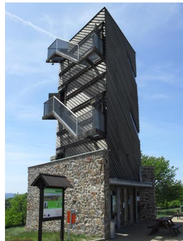
Rozhledna Velká Buková (15 km JV od Rakovníka) ÚT - NE 09:00 – 17:00 foto: Hana Hošková
